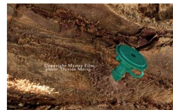
Fig. 10. sigillatura cannula
